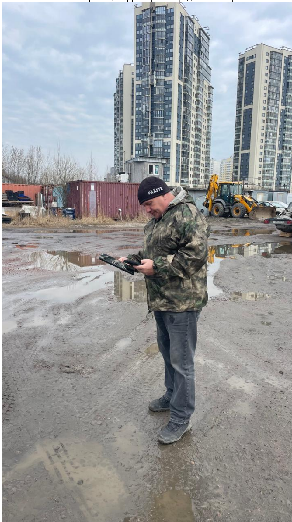
Фото 1. Уточнение границ территории перед началом работ.
